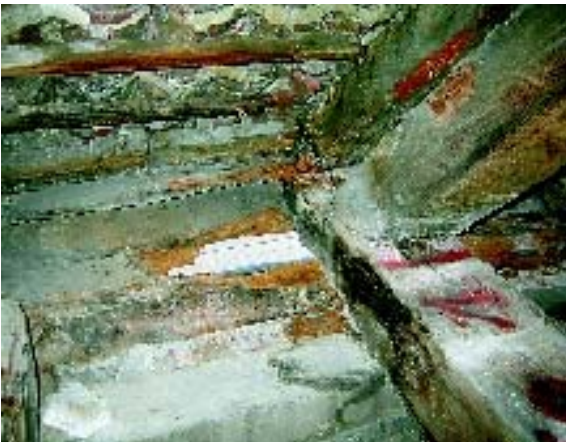
Nach der Entfernung von Schutt und zerstörter Holzsubstanz wird der Blick frei Richtung Kopfsteinpflaster
