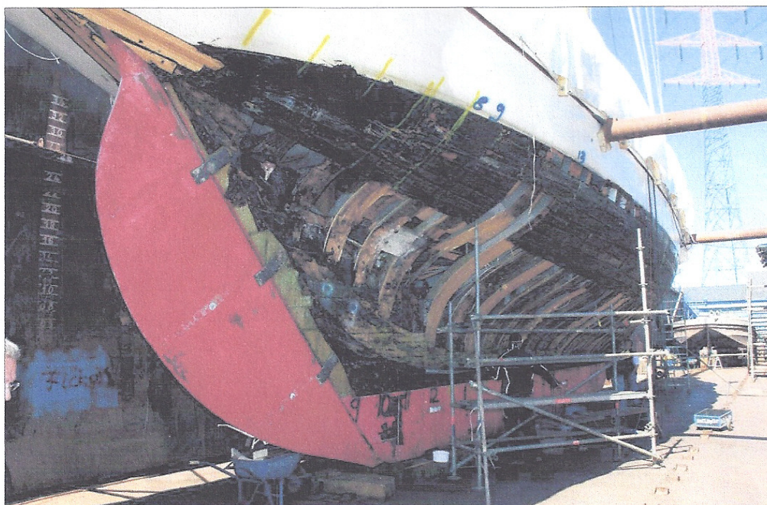
Die „Artemis“, teilweise schon freigelegt, im Dock: Der Pilz hat auch Spanten aus Eichenholz – die tragenden Teile des Schiffsrumpfs – angegriffen.
